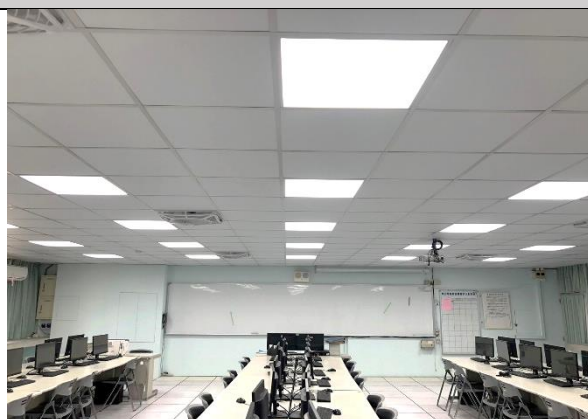
圖4 新設具吸音效果天花板及LED平板燈具，改善聲音傳導問題，照明光線均勻明亮
