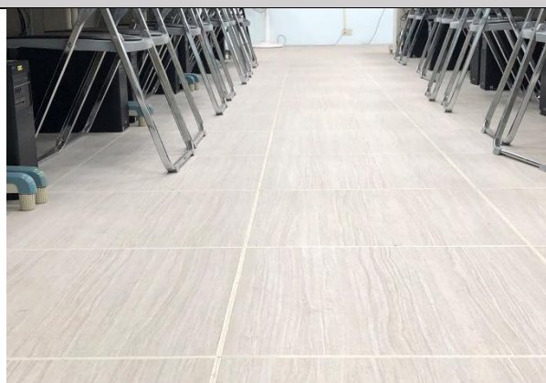
圖3 合金鋼高架地板完工後平坦平整，維護師生行走安全
