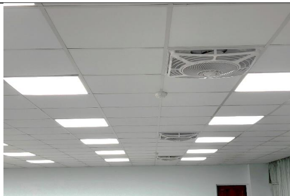
圖5 新設循環扇，改善室內空氣對流問題
