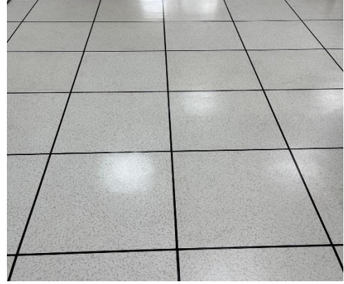
圖 6 地板改高架地板，替換原來已有部份翹起的木地板
