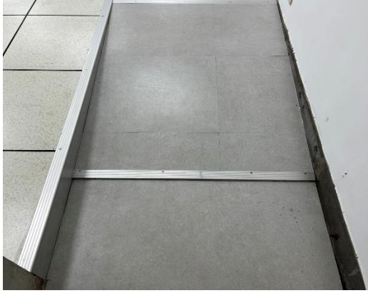
圖 5 二間教室均設置殘障坡道，方便特殊生輪椅進出
