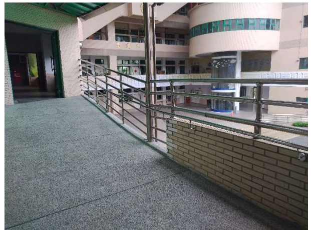
說明：忠孝樓 2 樓通道欄杆加高
