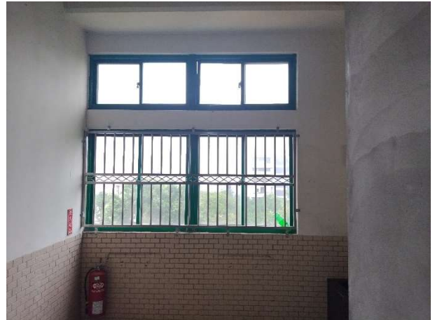
說明：志道 5 樓廁所鋁窗加裝安全護欄
