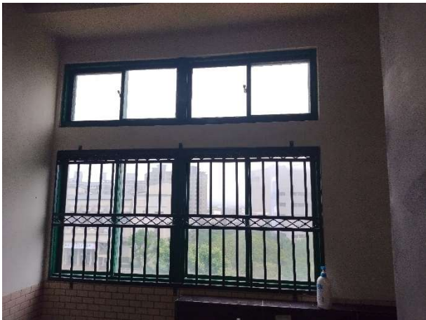
說明：志道 6 樓廁所鋁窗加裝安全護欄
