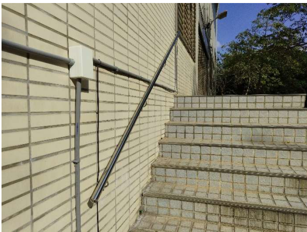
說明：游藝館側門安裝把手-後
