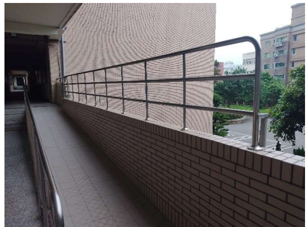
說明：和平樓 2 樓無障礙坡道欄杆加高
