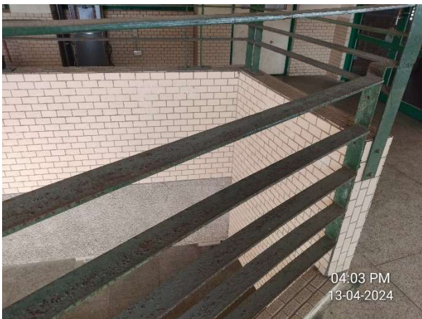
說明：志道樓走廊欄杆加高
