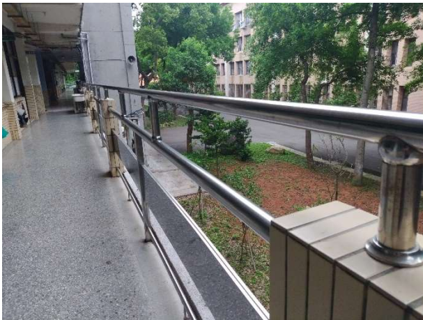
說明：信義樓走廊欄杆加高
