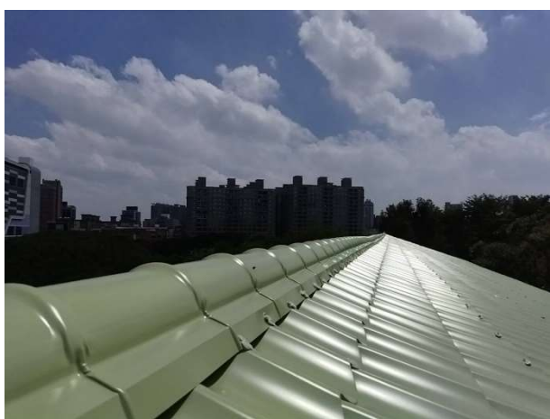
說明：信義樓等鐵皮屋頂修繕工程(112-13)-後
