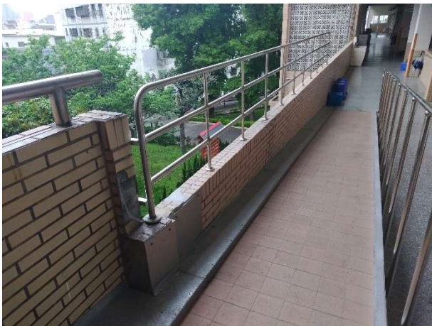
說明：和平樓 3 樓無障礙坡道欄杆加高
