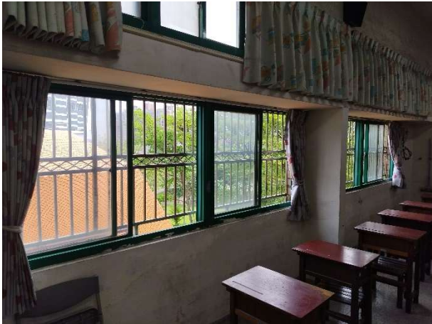
說明：志道 4 樓跑班教室鋁窗加裝安全護欄
