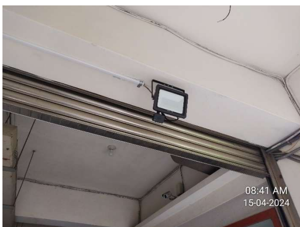
說明：志道大樓無障礙坡道感應燈 (提供夜間使用無障礙坡道時的照明)
