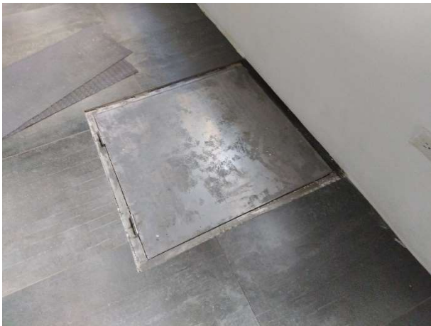
說明：圖館館路面鋪平-前
