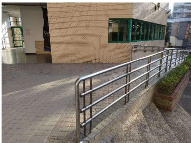
說明：志道大樓 1 樓扶手改善後(2)
