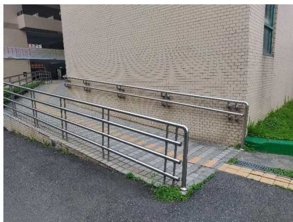
說明：志道大樓 1 樓扶手改善後(1)
