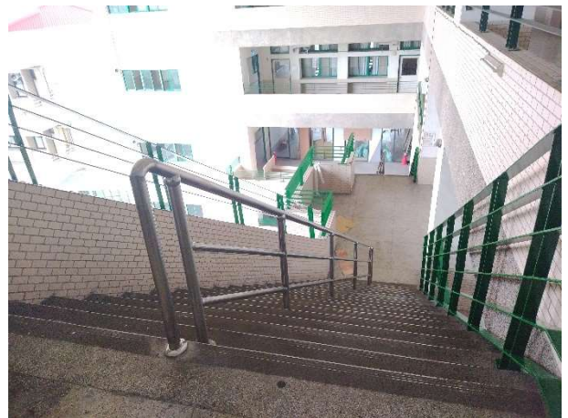
說明：志道大樓斜樓梯扶手改善-後
