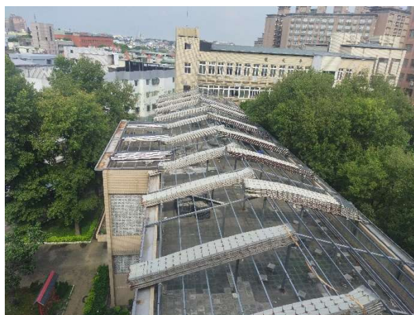
說明：仁愛樓樓頂無障礙坡道施工前
