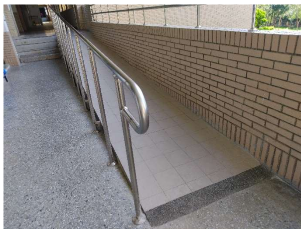
說明：仁愛樓 2 樓無障礙坡道整修-後
