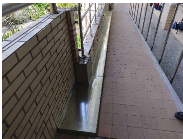
說明：仁愛樓 3 樓無障礙坡道整修-後
