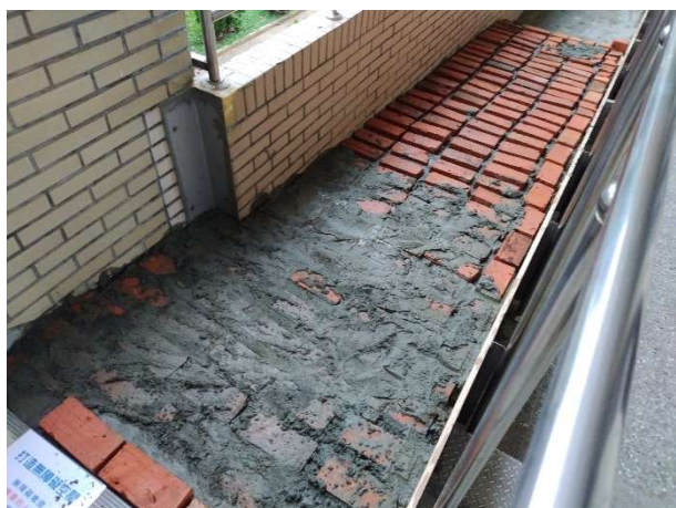
說明：仁愛樓 2 樓無障礙坡道整修-中 (原為木質坡道，使用時易有噪音干擾上課)
