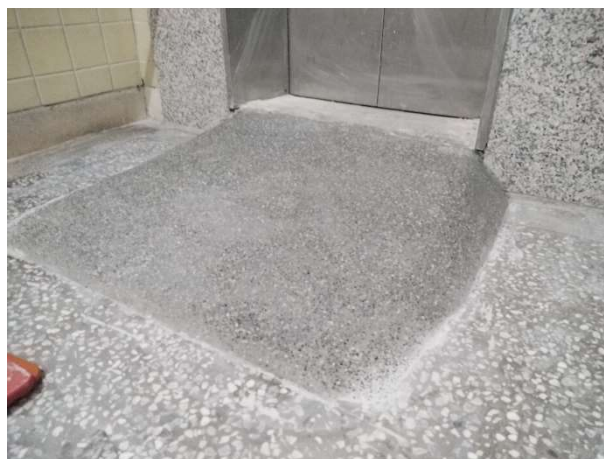
說明：行政 1 樓電梯斜坡
