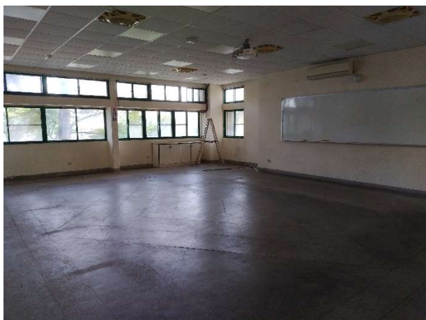
說明：志道二樓會議室-施工前(112-20)
