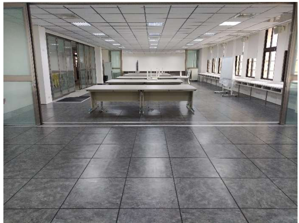
說明：行政 601 教室合金鋼高架地板-後(113-4)
